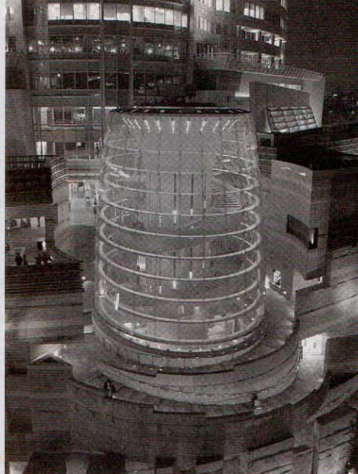
写真1 全体夜外観 (テレビ朝日ビル屋上より)
